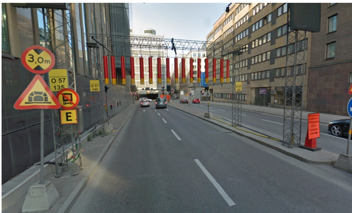
Foto 10: Infart till trafikplatsen som leder till Sveavägen börjar med förbudsmärken för begränsad fordonshöjd 3 meter och varningsskylt för tunnel. Därefter kommer barriär med hängande rör.
