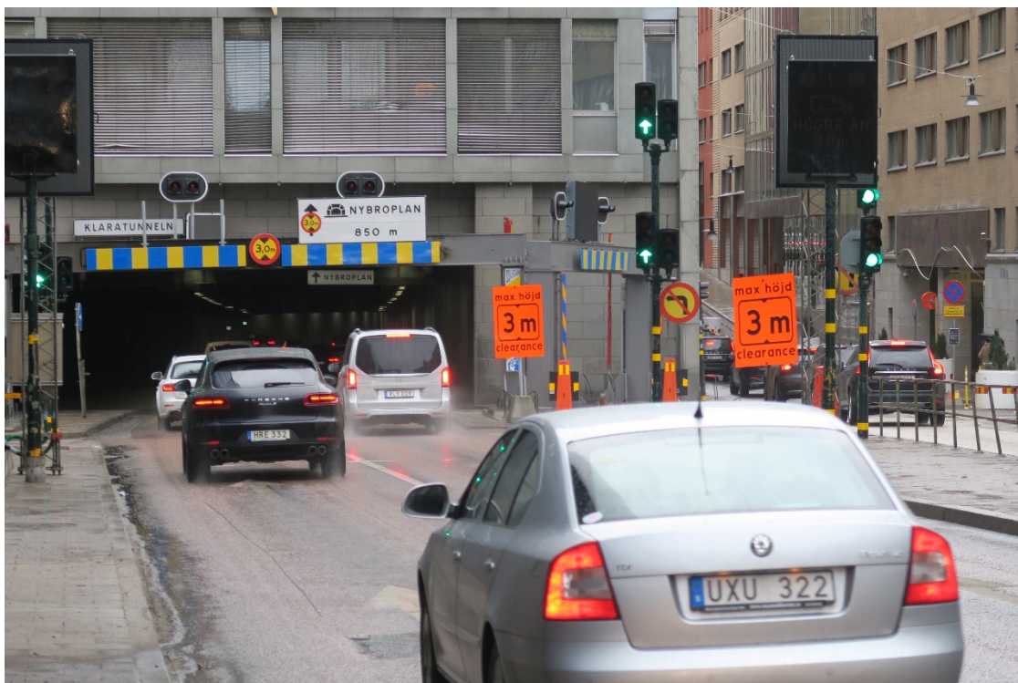
Foto 13: Elektroniska skyltar på båda sidor i trafikplatsen som aktiveras av den optiska barriären. På var sida om avtagsvägen åt höger finns tillfälliga orangea varningsskyltar som anger max höjd 3 m.
